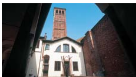
Portico e facciata ad intervento ultimato
