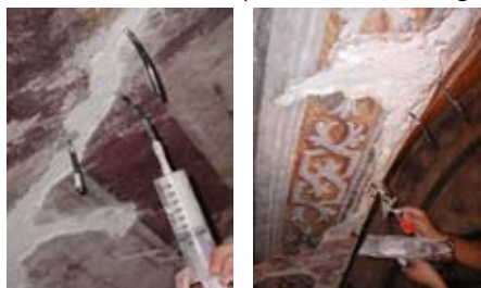
Consolidamento degli intonaci delle volte mediante iniezioni di Mape-Antique F21 | Applicazione di Mape-Antique FC
