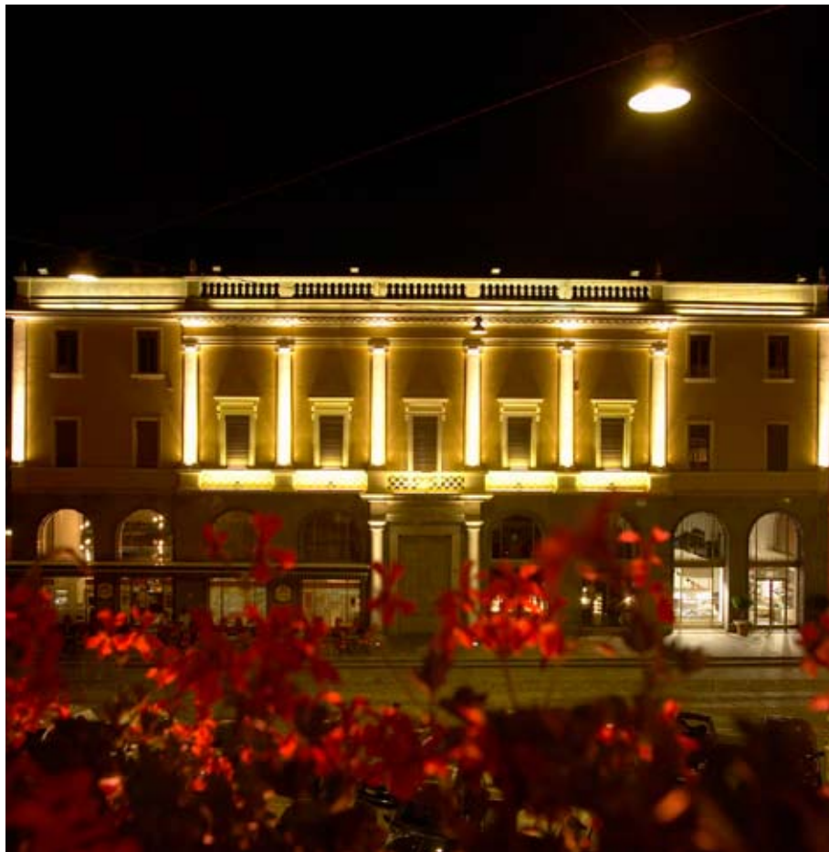
La facciata del Palazzo della Società Elettrica Sopracenerina
