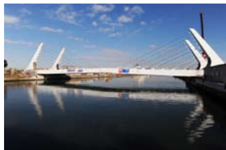
Il nuovo ponte mobile appena realizzato da Cmc sul Canale Candiano a Ravenna
