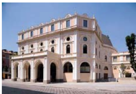
L'esterno del teatro - i lavori di restauro non ne hanno sostanzialmente alterato l'immagine
