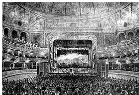
L'interno del teatro in un'immagine storica che mostra il precedente assetto della sala
