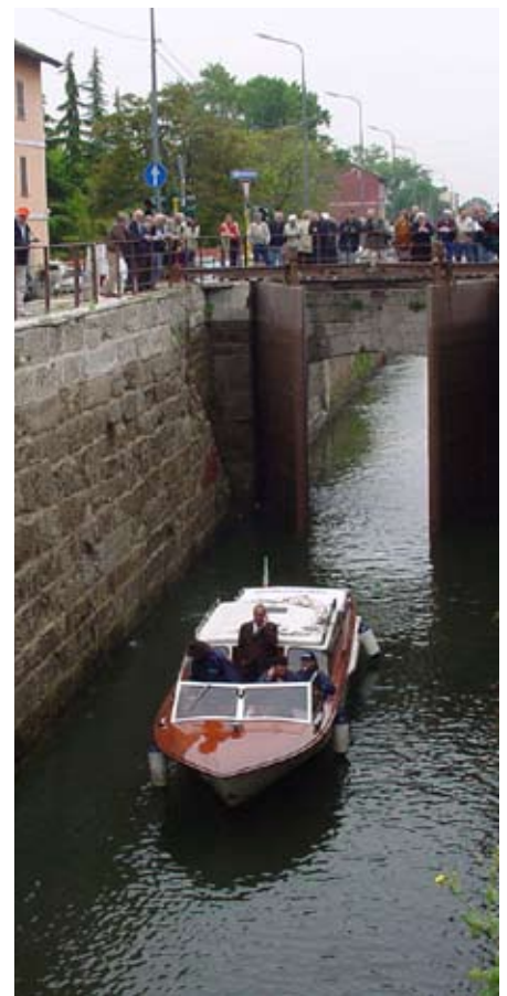
La Conca Fallata durante la prima prova tecnica nel 2006
