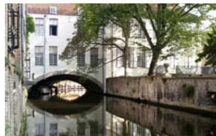
Canale di Bruges, Belgio (Foto MJJR)
