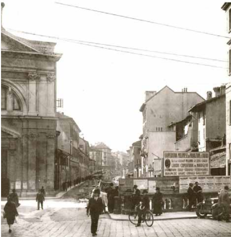
Copertura del Naviglio nel tratto di via De Amicis
